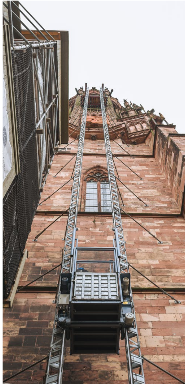
Der Baustellenaufzug am Münsterturm
