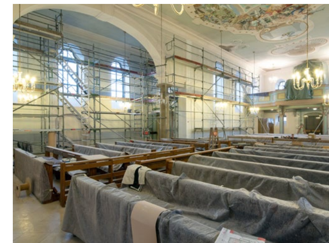
Der Innenraum der Kirche während und nach der Sanierung
